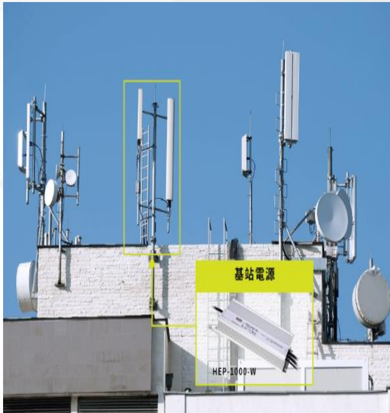
5G 基站設備
